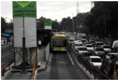
ਚਿੱਤਰ-6 : ਇੰਦੋਰ ਵਿਚ, ਇਕਹਿਰੀ ਬੀ ਆਰ ਟੀ ਲੇਨ ਦੀ ਸਮਰੱਥਾ ਆਮ ਆਵਾਜਾਈ ਵਾਲੀਆਂ ਦੇ ਲੇਨਾਂ ਵਾਲੀਆਂ ਨਾਲੋਂ ਕਿਤੇ ਵੱਡੀਆਂ ਹਨ।
