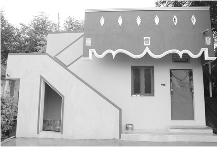
பசுமை இல்லத் திட்டத்தின் கீழ் கட்டப்பட்ட வீடு
